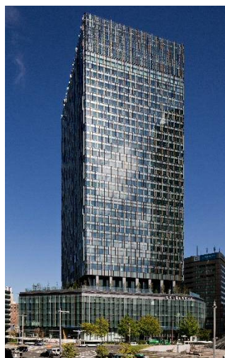
▲大名古屋ビルヂング
